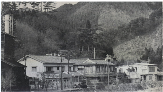
籠坊温泉 (阪急電車池田駅よりバス・三田市よりバス) およそ800年の昔、平家の落武者が発見したといわれ、全く俗界をかけたはなれた仙境の地である。四季を通じて阪神間の湯客に親しまれている。
